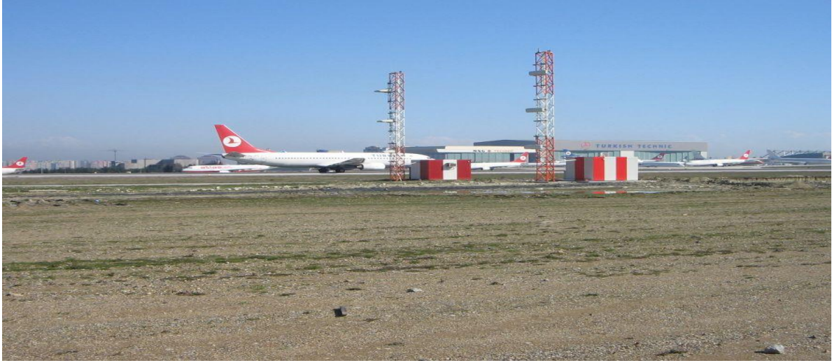
Glide-Path Anteni ve Cihaz Barınağı
